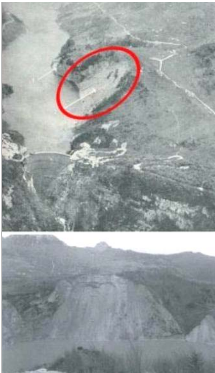
Fig. 8 – Panoramica e visione frontale della superficie di distacco della frana del 04/11/1960.
